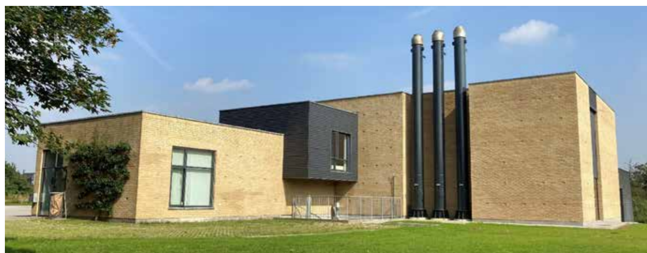
Den nye tilbygning er placeret til højre for skorstenene
